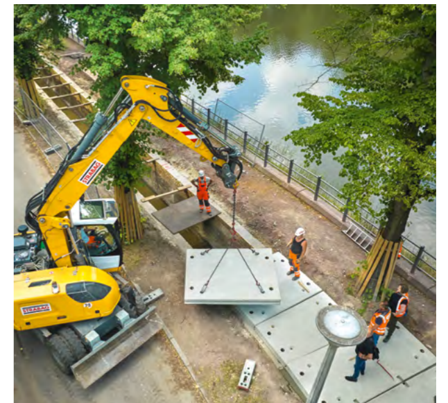
Halles Riveufer: Hier wurde eine Mammutaufgabe planmäßig in knapp einem Jahr gemeistert.
